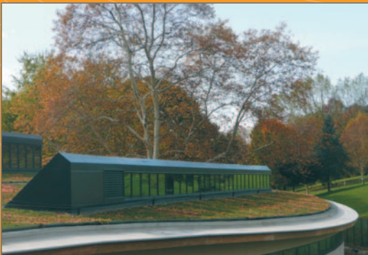
Sur la toiture végétalisée qui permet d'obtenir une meilleure inertie thermique été comme hiver, des panneaux solaires thermiques contribuent à la production d'eau chaude sanitaire du centre aquatique.
